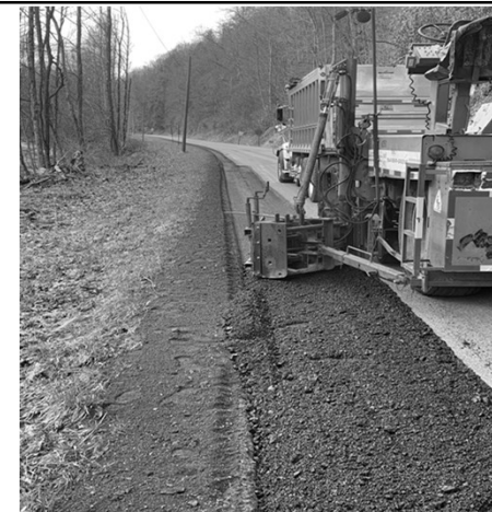
Edge Failure Repairs
